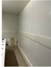
Die neue Kühlraumverkleidung mit den großformatigen PVC-Platten weist deutlich weniger Fugen auf.
