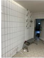
Der Kühlraum vor der Sanierung mit herkömmlicher Fliesung
