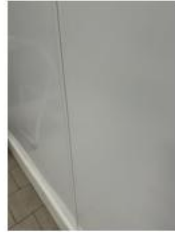
Die neue Kühlraumverkleidung mit den großformatigen PVC-Platten weist deutlich weniger Fugen auf.
